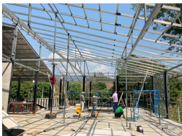
皆さまの支援金により建設中の新しい研修寮
